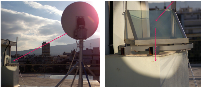
Έργο εκτροπής του ηλιακού φωτός σε φωταγωγό στα γραφεία της Στίλβη Φωτισμός ΕΠΕ. Το φυσικό φως προσπίπτει σε υαλοπίνακα που φέρει ολογραφικό υμένιο το οποίο λειτουργεί πρισματικά. Το φώς εκτρέπεται σε κατακόρυφη διεύθυνση, όπου και αναλύεται φασματικά με το κυρίαρχο μήκος κύματος και αντίστοιχο χρώμα φωτός να αλλάζει ανάλογα με τη γωνία πρόσπτωσης και το ύψος του ήλιου στον ορίζοντα με αποτέλεσμα ο χρωματισμός να λειτουργεί σαν ηλιακό ρολόι προσδίδοντας στον χώρο βιορρυθμό με χαρακτηριστικό το χρώμα, αντί της σκιάς στη γνωστή πρώτη μορφή ηλιακού ρολογιού Project diverting sunlight into a light-shaft at the offices of Stilvi Lighting Ltd. The natural light falls upon plate glass bearing a holograph membrane which serves as a prism. It is diverted in a vertical direction. It is broken down on the spectrum by the dominant wavelength and corresponding colour of light, changing with the angle at which it falls and the height of the sun on the horizon. The result is that the colouring serves as a sundial, lending the space a biorhythm with colour as its characteristic instead of the shadow in the early form of the sundial with which we are familiar
